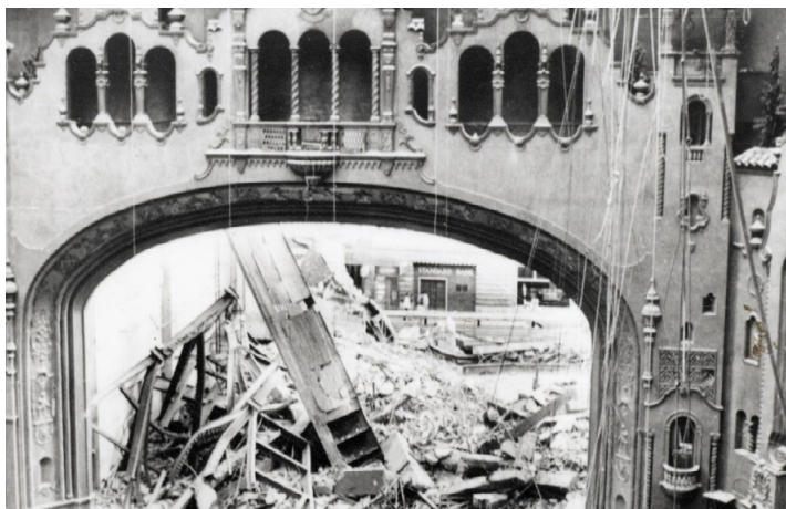
Figura 2 – Palco e interior do Alhambra durante a demolição
