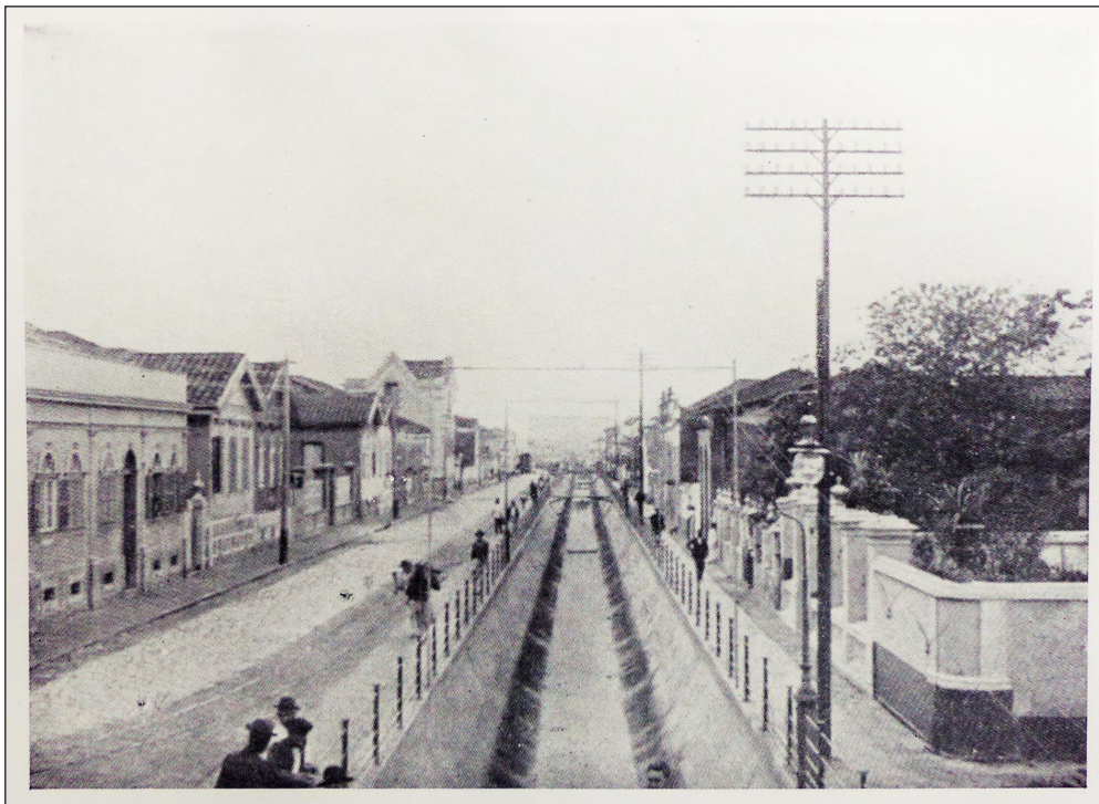
Figura 3 – Francisco Rodrigues Saturnino de Brito. Saneamento de Santos : Canal – Trecho na rua Rangel Pesata (concreto armado). Fonte: Francisco R. Saturnino de Brito (1943, v. VII, est. XII, p. 98).
