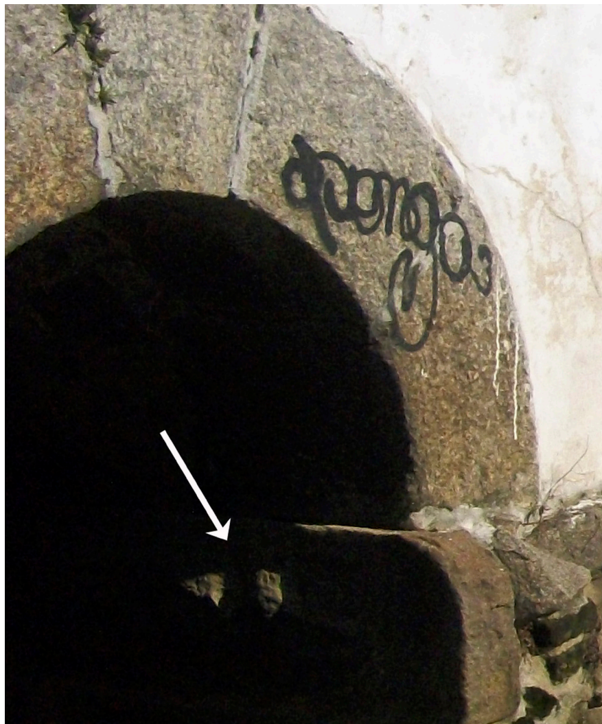
Figura 40 – Provável ponto de amarra de barcos junto a entrada de um dos túneis centrais. Foto da autora (2018).
