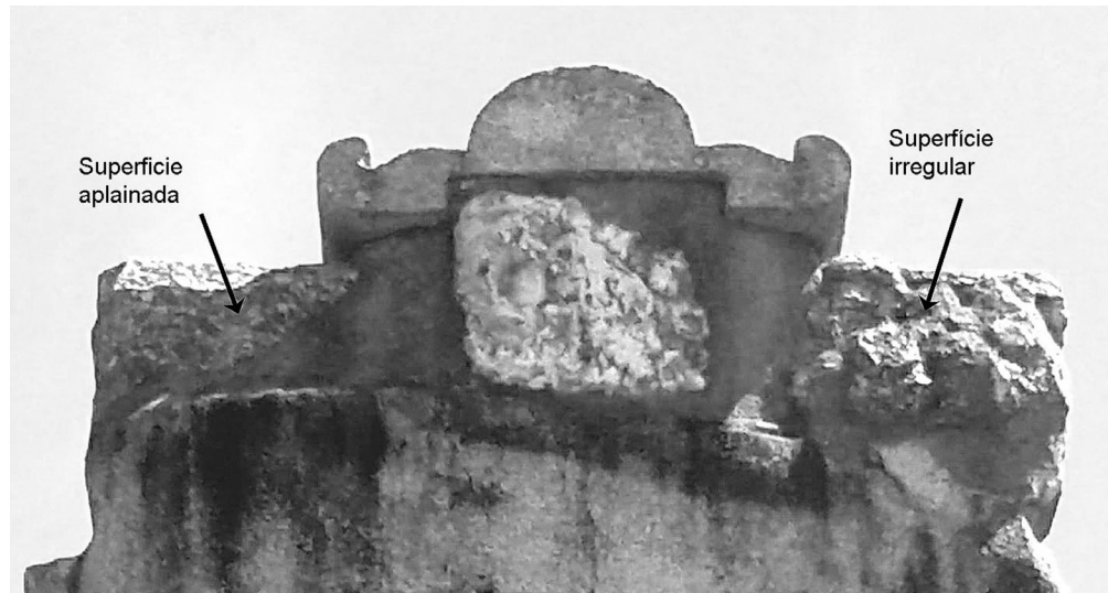
Figura 28 – Verso do dístico (observar diferença de acabamento do bloco à esquerda e à direita do calcário). Fotografia da autora (2018).
