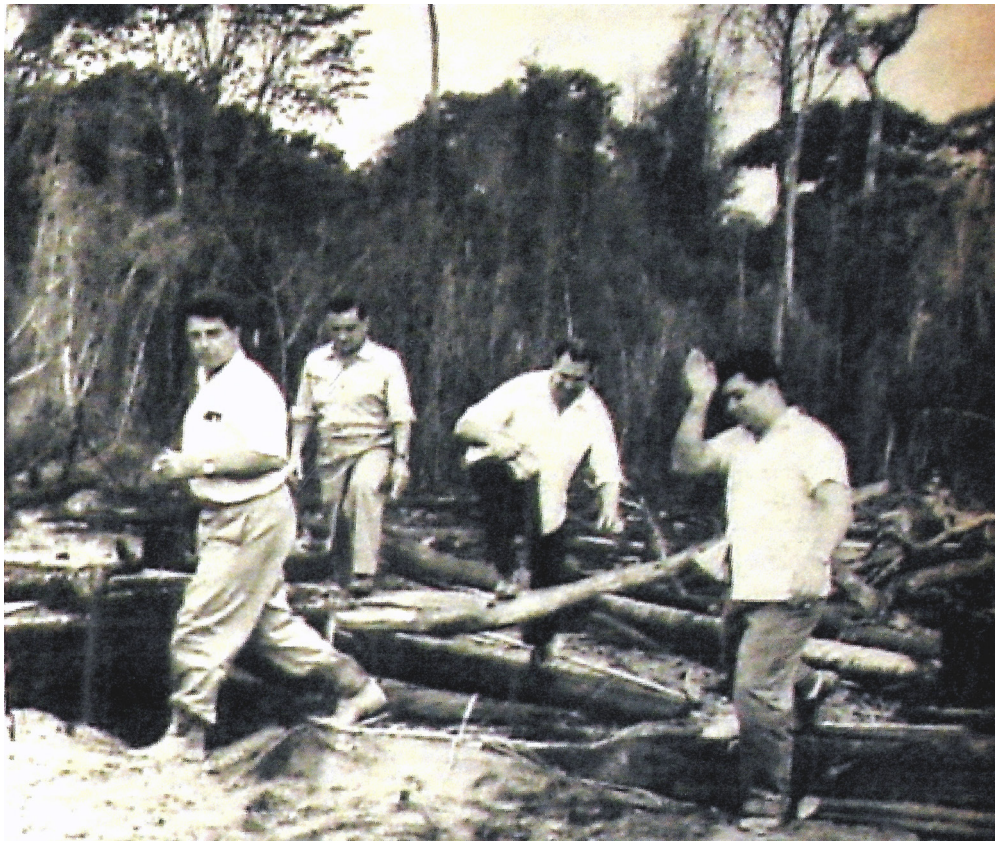
Figura 3 – Bernardo Sayão, Waldir Bouhid e outros na construção da estrada. Fotografia não identificada, 1960. Fonte: PIERRE, Arnaud. Primeira viagem na Belém-Brasília . Rio de Janeiro: SPVEA, 1960. ( Cadernos Belém-Brasília , v. 4).
