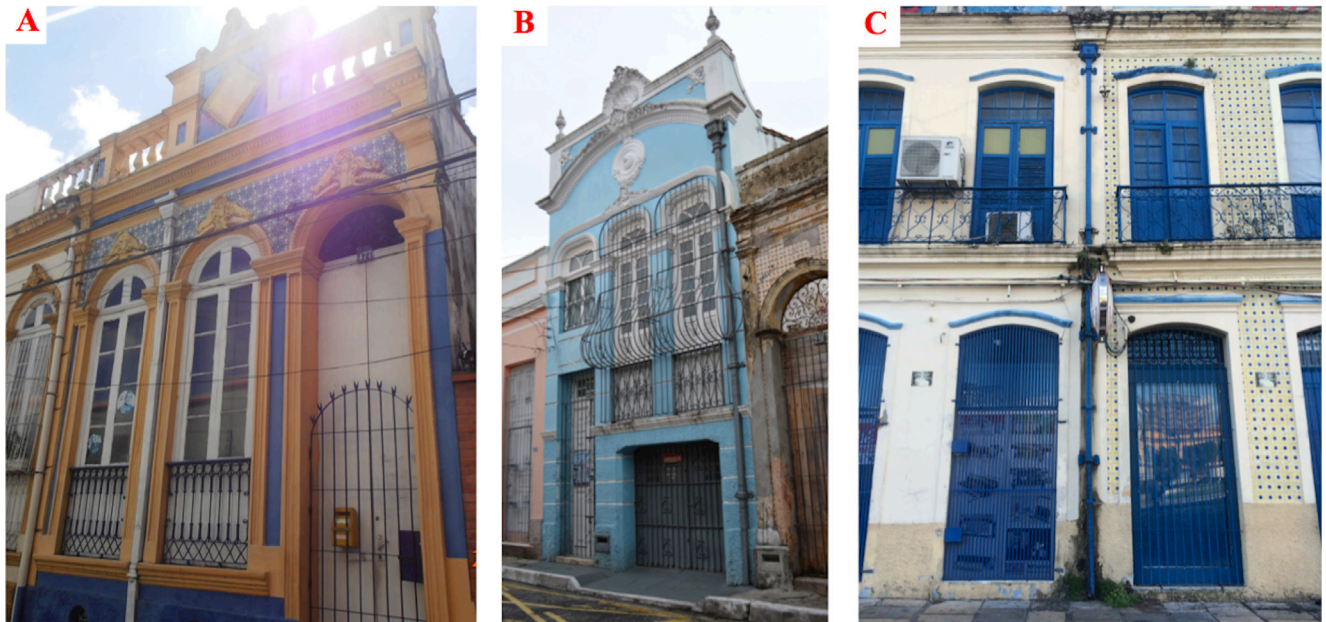
Figura 11 – Fachadas com estudo cromático que destacam os dutos verticais e demais componentes metálicos. Fonte: Fotografias das autoras.
