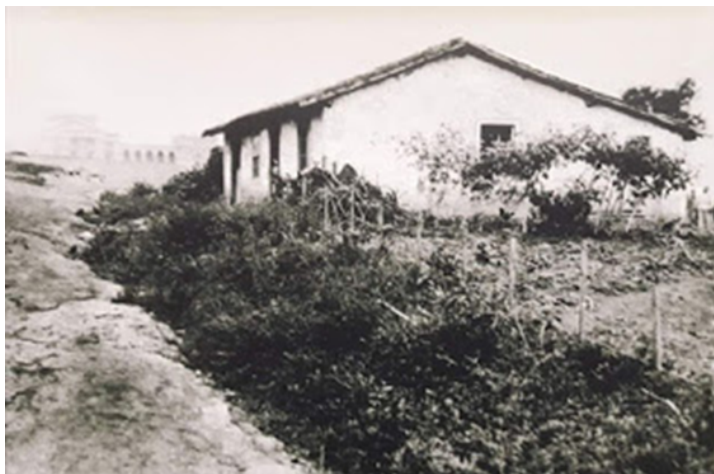
Figura 26 – A chamada Casa do Grito, em 1920. Notar as voçorocas no caminho e o museu ao fundo. Fonte: Acervo do Museu Paulista.
