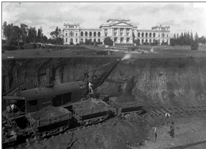
Figura 22 – Escavação de terra na altura da rua dos Patriotas, para a implantação do jardim francês, 1921. Fonte: Acervo do Centro de Memória Unicamp.
