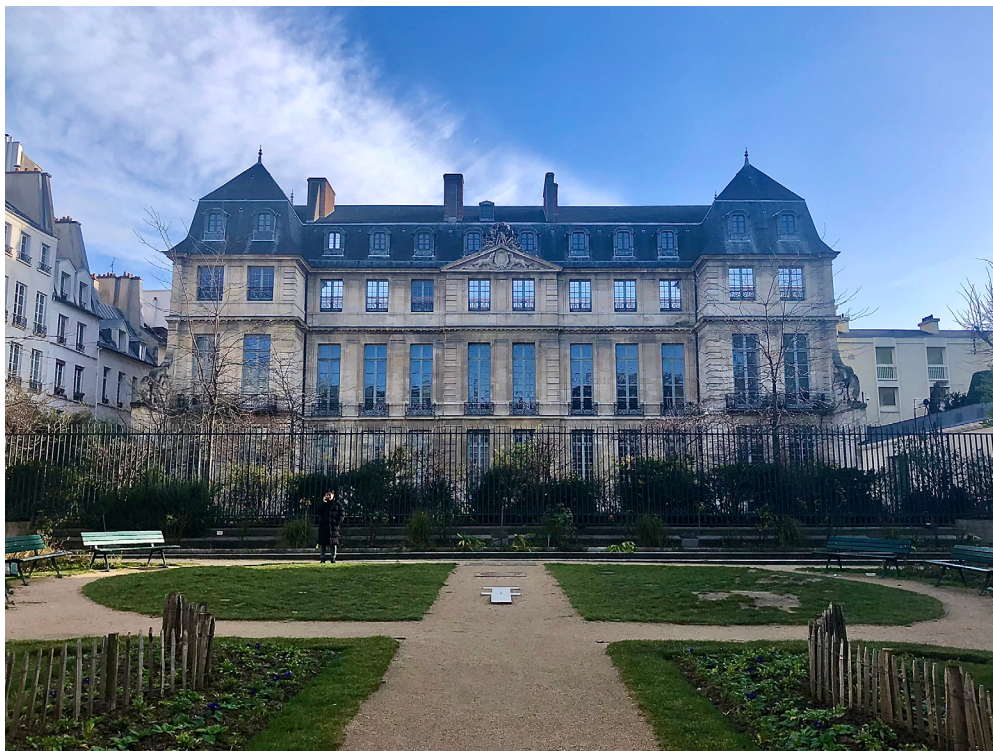
Figura 29 – O edifício depois da restauração realizada na década de 1970. Foto: Maria Regina Weissheimer.
