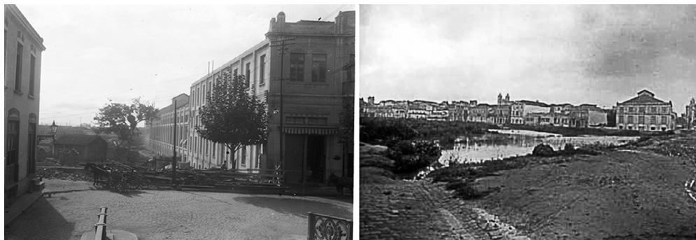
Figura 27 - Vista da Ladeira da 25 de Março em direção à Várzea do Carmo, onde seria aberta a Rua Carlos de Sousa Nazaré. Fotógrafo desconhecido, c. 1912-1916. MCSP; vista para a Várzea de Santa Rosa, onde se vê o fundo da oficina, cuja entrada era na Rua 25 de Março. Aurélio Becherini, 1918. MCSP.
