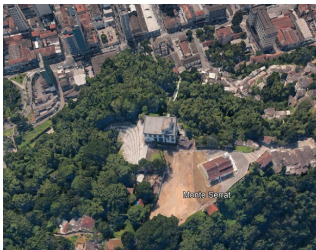
Figura 16 – Vista aérea do Monte Serrat. Em seu topo, foi instalado o primeiro ponto da linha telegráfica. A capela com telhados avermelhados e o antigo cassino com teto plano. Fonte: Google Earth Pro.
