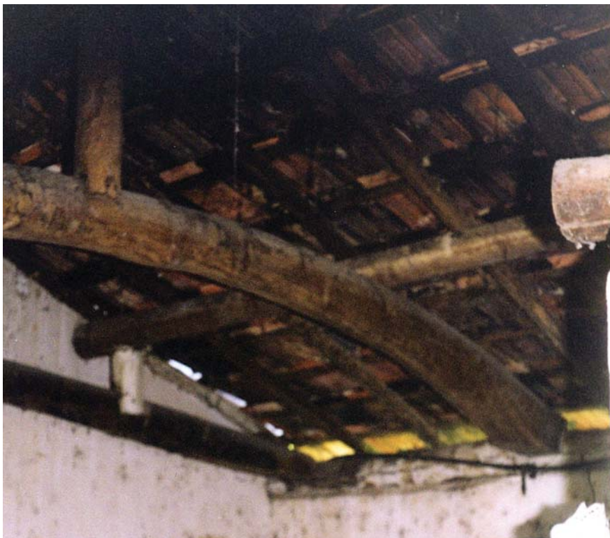
Figura 4 – Interior da moradia da família Kawagushi, onde se vê a viga principal de suporte da estrutura de cobertura em madeira roliça e forma encurvada. Fotografia do autor.
