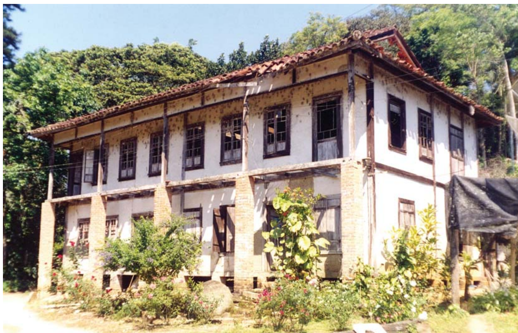
Figura 19 – Fachada principal da moradia da família Shimizo, cuja cobertura é ao estilo irimo-ya com telhas de barro francesas. Fotografia do autor.
