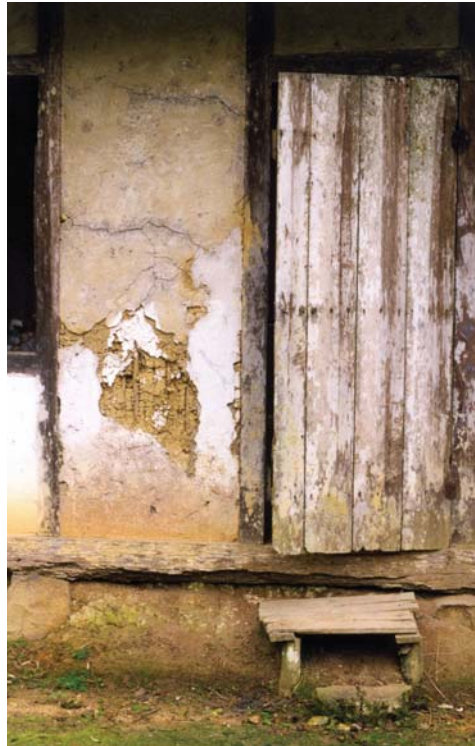
Figura 9 – Fundação em pedra da moradia da família Okiama. Fotografia do autor.
