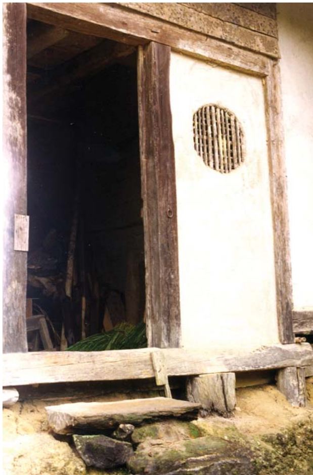
Figura 24 – Detalhe da ventilação da área –de cocção do genkei do sr. Gozo Okiama. Fotografia do autor.
