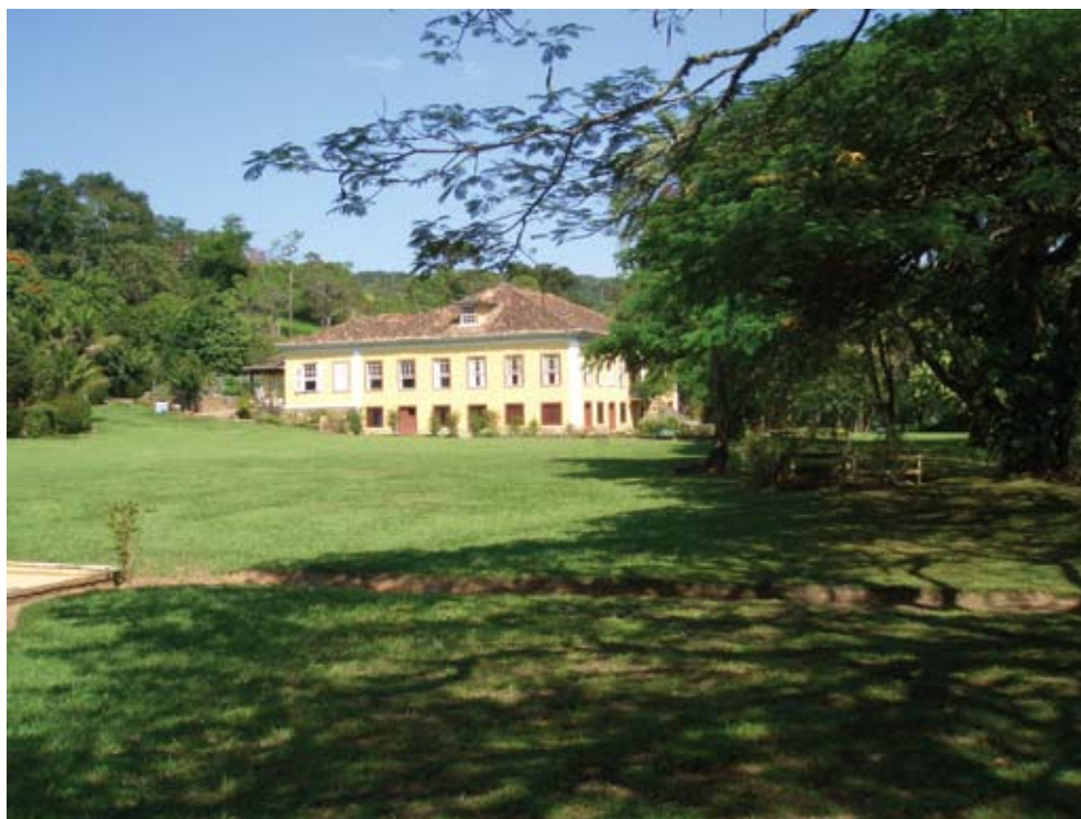
Figura 2 – Vista lateral da casa de vivenda da fazenda Resgate, Bananal, São Paulo. Fotografia de Rafael de Bivar Marquese.
