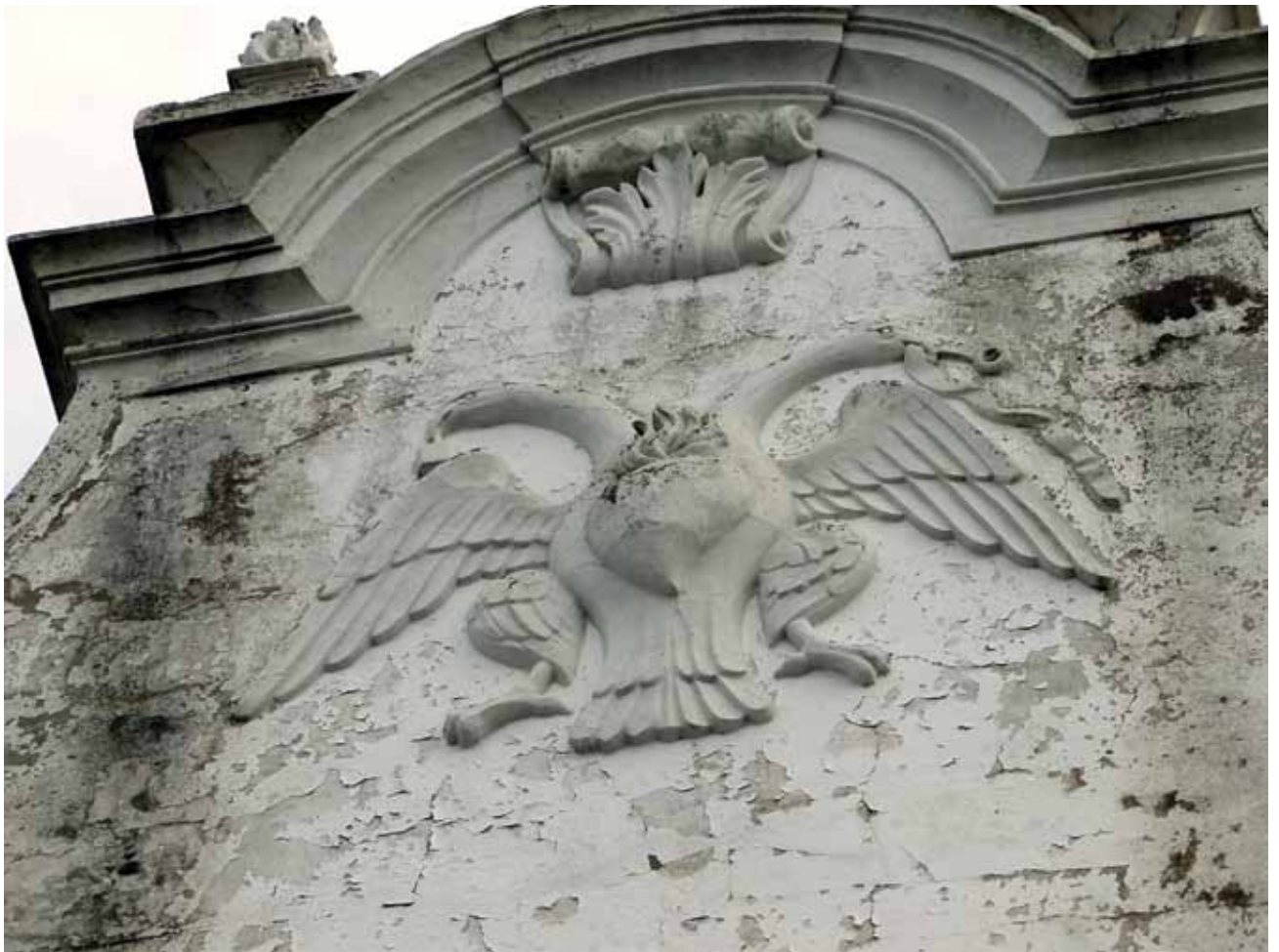
Figura 4 – Uma águia bicéfala em relevoorna o centro do frontão da igreja do convento de Nossa Senhora das Mercês, da Ordem dos Padres Descalços de Santo Agostinho, na cidade de Évora, Portugal. As obras de construção ocorreram no último quarto do século XVII. Fotografia do arqueólogo António Carlos Silva, Évora, 2010 (cortesia).
