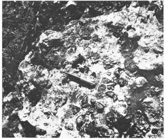
Foto 4 - Aspecto brechóide devido a "manchas arenosas" ressaltadas por lixiviação pluvial. Local - Faz. São José (Borebi, SP).
