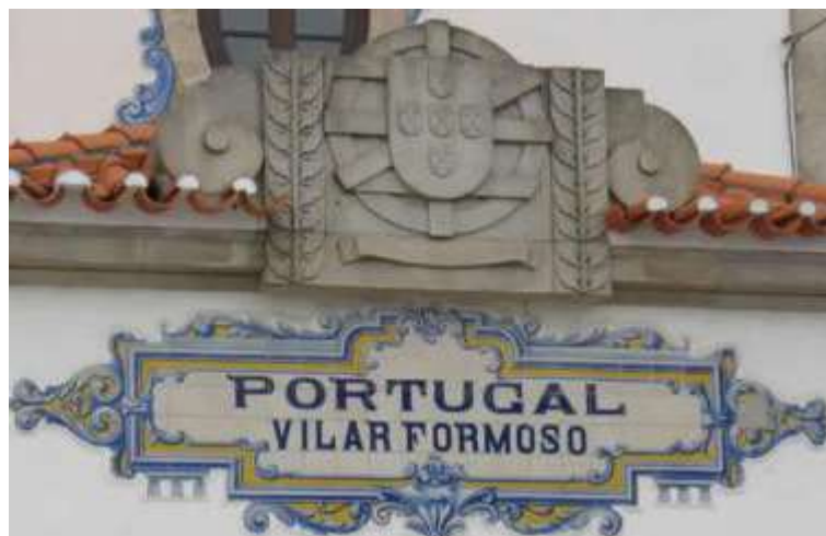
Figura 1 Frente da estação ferroviária de Vilar Formoso
