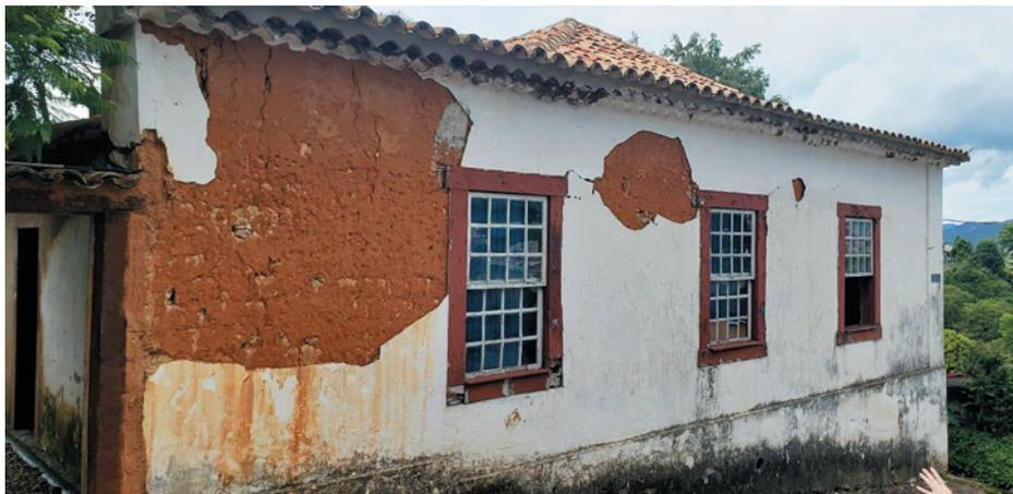
Por meio do teste de percussão,<sup>11</sup> constatou-se o desprendimento quase total da camada de revestimento em todas as fachadas (Figura 8). Essa aceleração da degradação do revestimento das fachadas nos últimos anos nos levou à seguinte hipótese: teria sido o uso da argamassa cimentícia, em intervenções anteriores, um dos fatores dessa aceleração? Seguramente.
