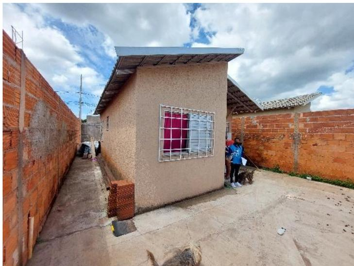
**Figura 8.** Exemplo de HIS no 2A4, onde é possível observar uso de telhas em concreto e implantação do embrião isolado no lote (fundo).
