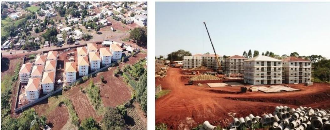
**Figura 3.** Execução de Edifícios Multipavimentos em Wood Frame.
