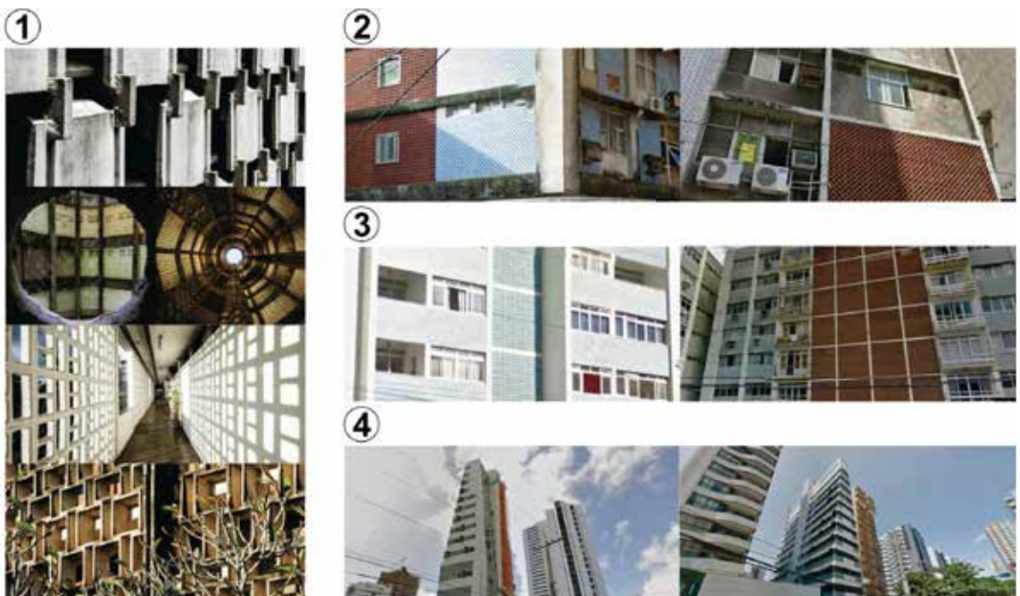
Figura 2: Imagens extraídas de Vieira et. al. (2012) mostrando em detalhe o uso do Cobogó em edificações de substancial valor arquitetônico na cidade do Recife; (2) Situações em que o ar-condicionado passou a ser utilizado como principal instrumento para adequar ambientes internos. Na imagem à esquerda verifica-se que o Cobogó foi retirado em parte da fachada original; (3) Edifícios residenciais padrões da cidade. Neste caso é possível observar o corriqueiro o uso de elementos vazados; (4) Edificações contemporâneas, com o mesmo projeto, seguindo diferentes orientações no terreno. Fonte: elaboração própria.
