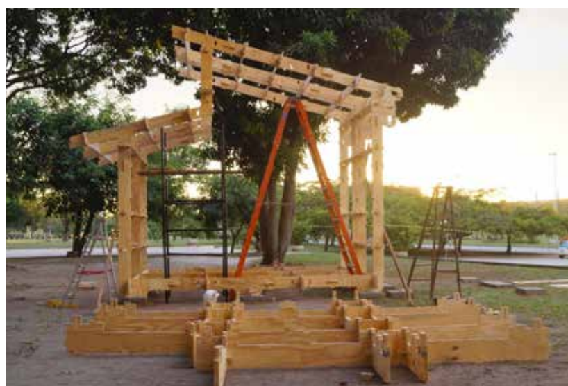
Figura 13: Estrutura de fechamento final pré-montada para encaixe no pórtico. Acervo dos autores.
