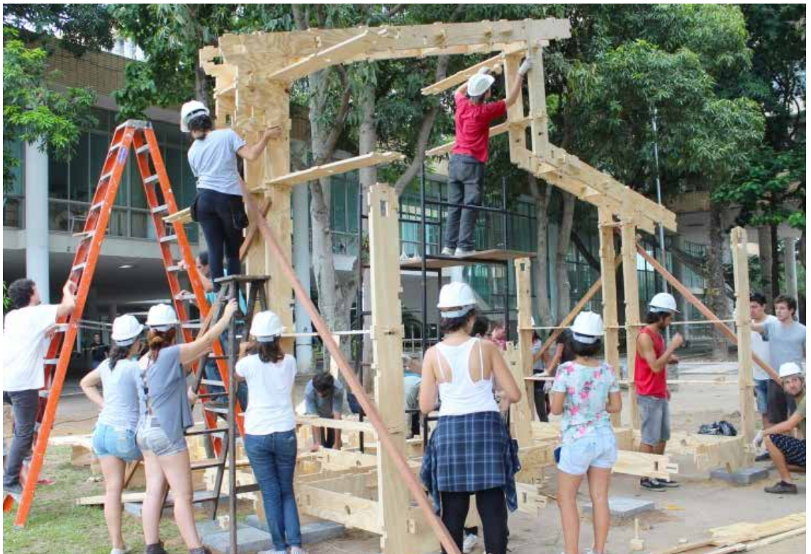
Figura 12: Montagem da estrutura realizada por alunos da FAU-UFRJ. Acervo dos autores. .
