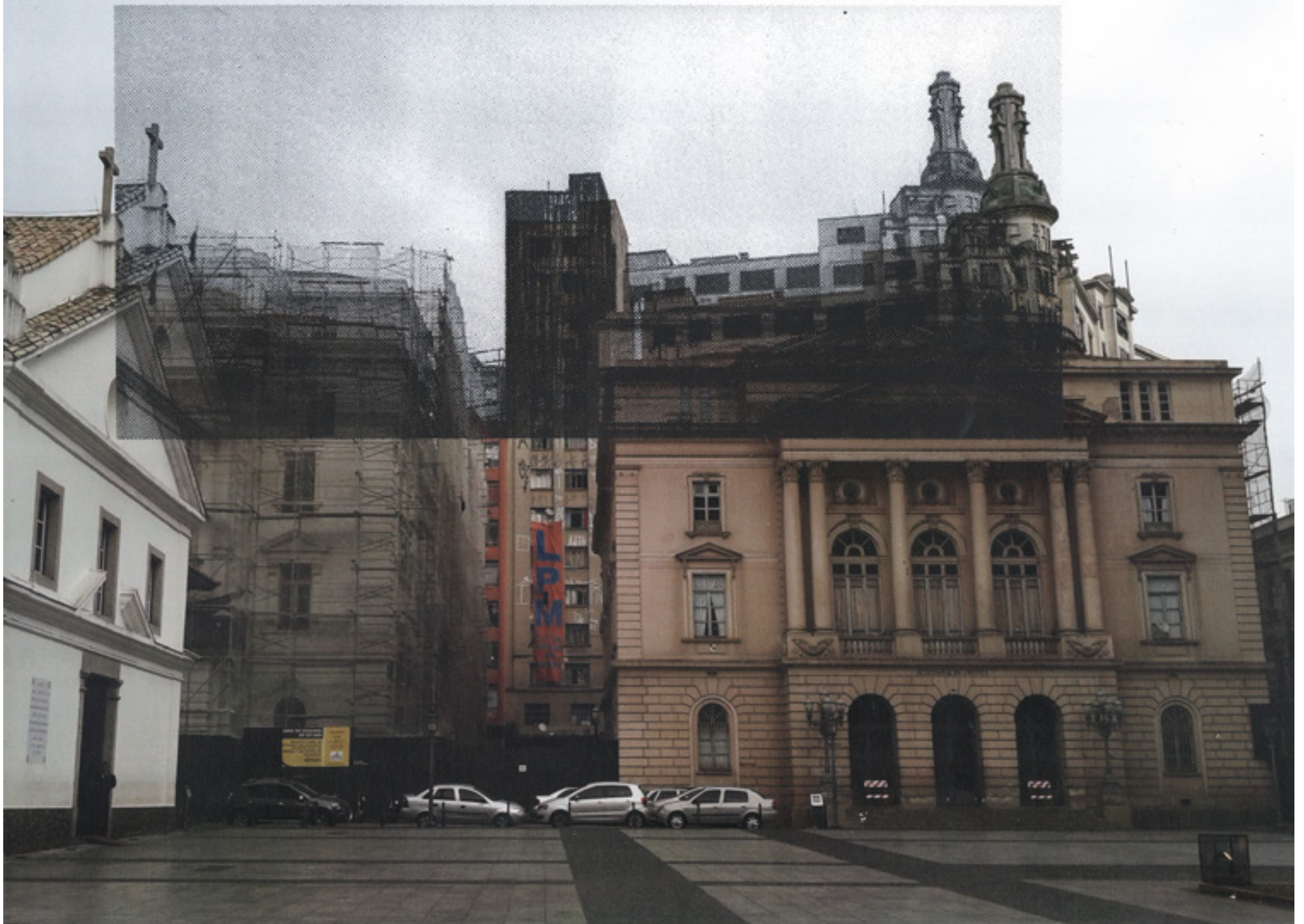
241 Edifício Rua Floriano Peixoto s/n. Abandonado há 8 anos, ocupado desde abril até agosto de 2014. Ensaio de Vivian Javiera Castro Villarroel
