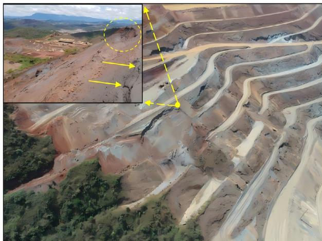
Figura 16. Condições dos taludes em setembro de 2020, com destaque para a ruptura plano-circular e trincas no topo da berma.
