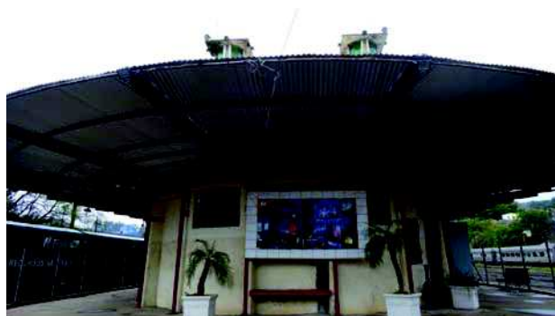
Figura 6: Estação ferroviária tombada (2015). Fonte: Acervo pessoal dos autores.
