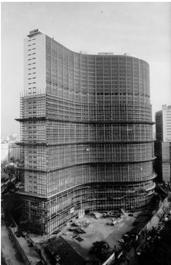
Figura 5 – Fase final da construção do Copan Fonte: Acervo do Condomínio Copan.
