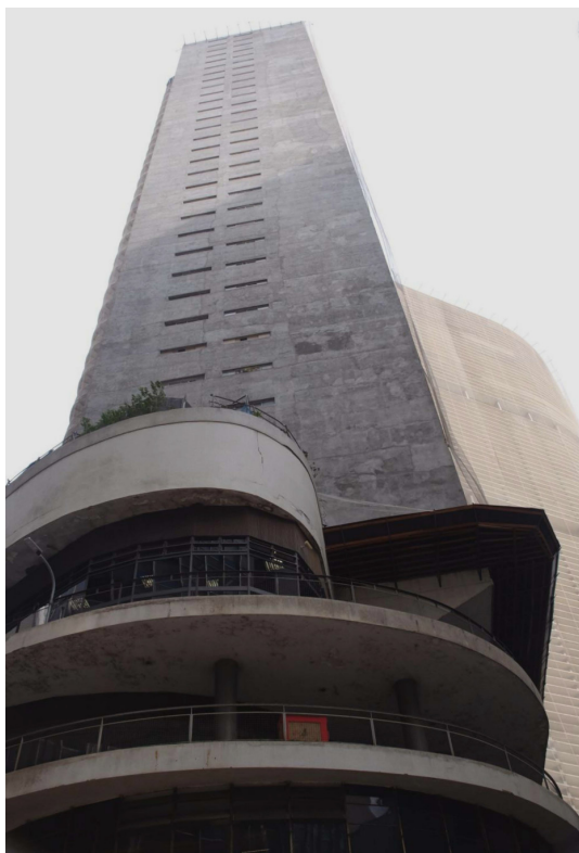
Figura 9 – Vista parcial da Fachada Noroeste e Principal com a tela de proteção Fonte: Acervo da autora.
