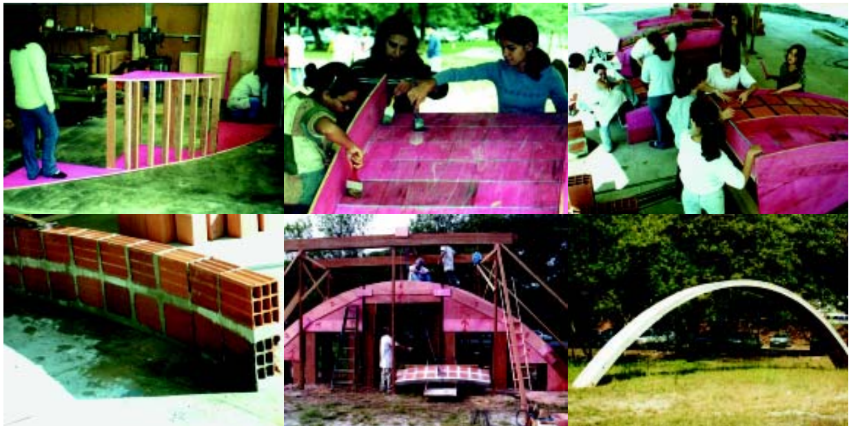
Arco em painéis pré-moldados de cerâmica armada. Referência: engenheiro Eladio Dieste
