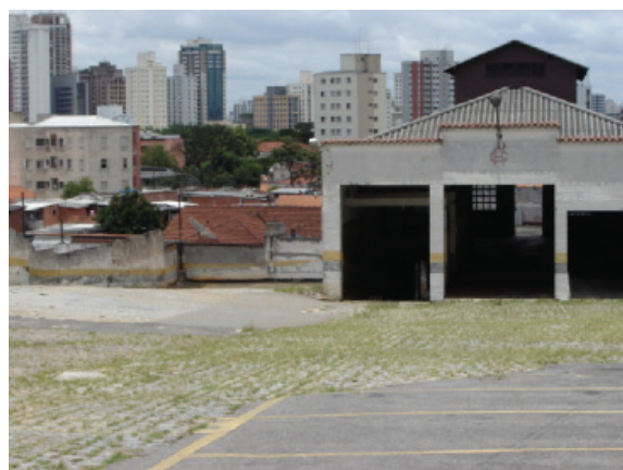
Figura 11: Imóvel desocupado na rua Rio Grande, a cavaleiro do córrego Foto: Autor
