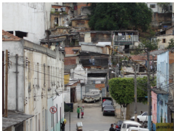
Figura 37: O córrego recebe um afluente na altura da rua Ubá Foto: Autor
