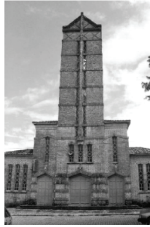
Rio Tinto, Paraíba Casas e igreja edificadas pela Companhia de Tecidos Rio Tinto, 1995 e 2001
