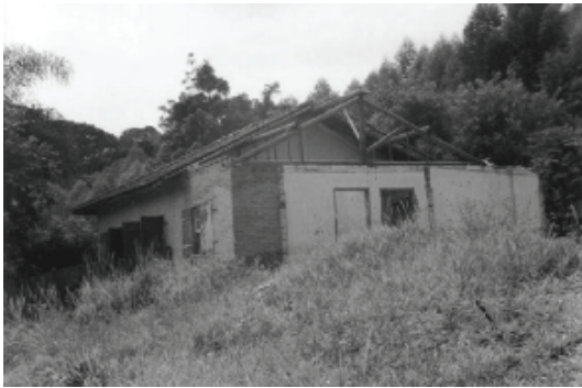
Caieiras, São Paulo Demolições no núcleo residencial criado pela Companhia Melhoramentos S.A., 2002
