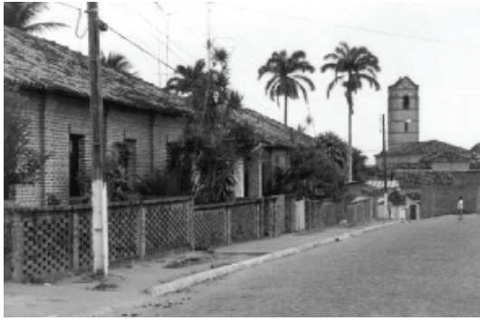
Rio Tinto, Paraíba Casas e igreja edificadas pela Companhia de Tecidos Rio Tinto, 1995 e 2001
