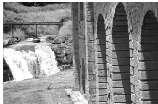
Iperó, São Paulo Prédios fabris da Real Fábrica de Ferro de São João de Ipanema, 2001
