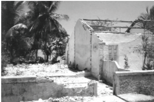
Recife, Pernambuco Casas sendo demolidas na Vila Iolanda criada pela Fábrica Iolanda, 1996
