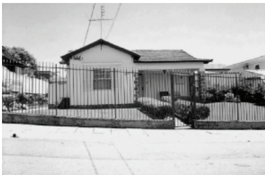
Volta Redonda, Rio de Janeiro Casas, alojamento para solteiros e prédios de apartamentos construídos pela CSN, 2001
