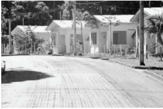
Três Marias, Minas Gerais Casas no núcleo residencial da Companhia Mineira de Metais, 1998
