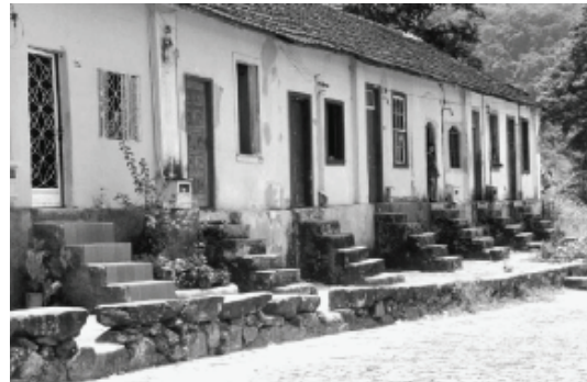
Petrópolis, Meio da Serra, Rio de Janeiro Casas erguidas pela Companhia de Fiação Cometa, 1998
