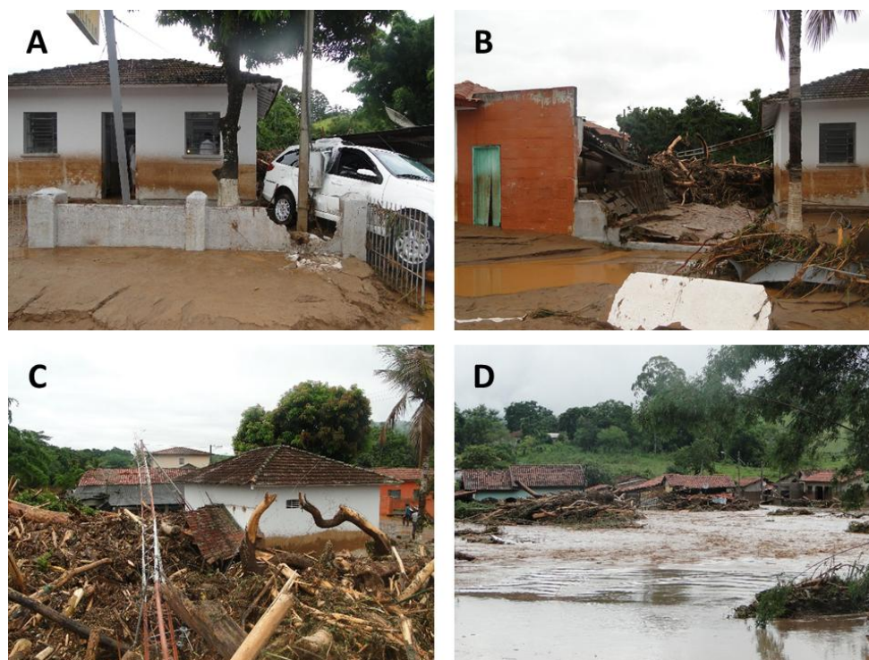
Figura 2:  rea urbana do munic pio de Itaoca, SP, afetada por fluxo de lama em 2014. A) Danos causados pela inunda o. Nota-se o alcance da  gua dado pela marca na parede; B) Edifica o destru da por detritos lenhosos; C) Ac mulo de material mobilizado pela inunda o; D) Inunda o que atingiu as edifica es em Itaoca. Fonte: Prefeitura de Itaoca, SP.
