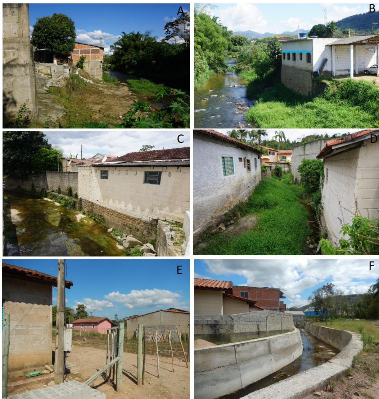
Figura 6: Exemplos dos tipos de edificações presentes na área de estudo. A e B) Edificações às margens do Rio Palmital (nota-se a ausência de muro), a linha em azul indica o alcance da inundação de 2014; C e D) Edificações às margens do afluente do Palmital, uma área com a maior concentração de Muito Alta Vulnerabilidade; E) Edificação no Setor Sul, nota-se a ausência de muros; F) Edificação às margens do afluente, nota-se a presença de muro de alvenaria.
