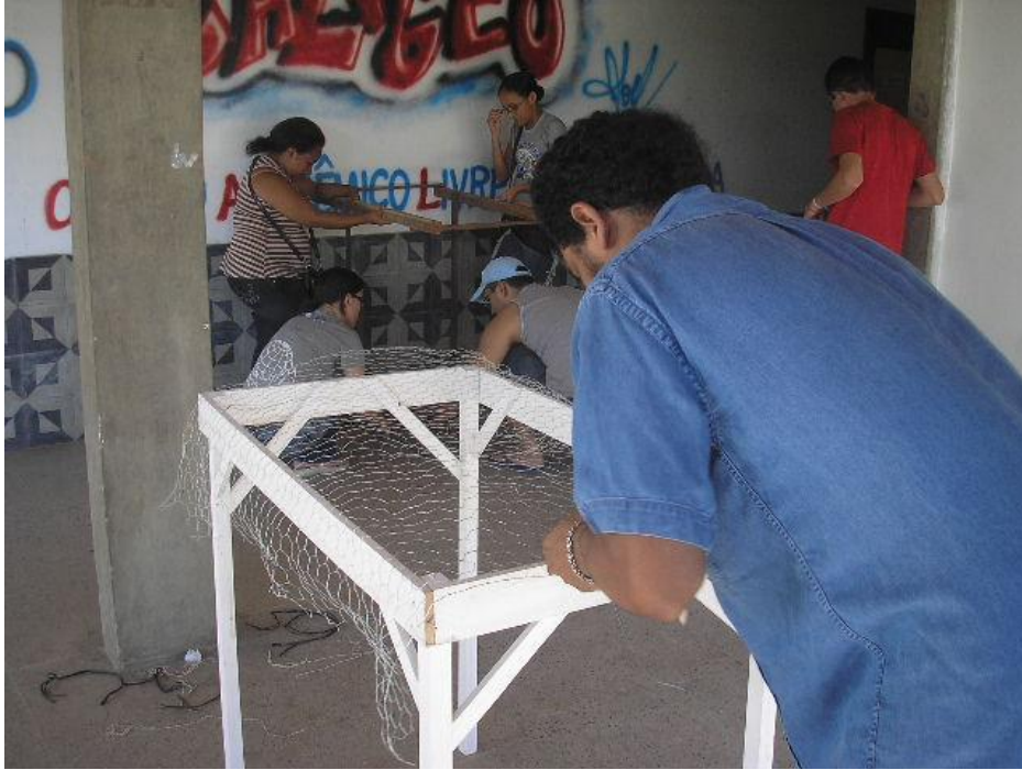
Ilustração-1. Em construção as instalações
