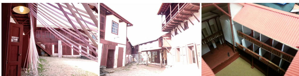
Figura 21. Pátio interno com fachadas, esquadrias e guarda corpos de madeira recuperados, apresentando similitudes com a maquete de um Corral de Comédia do século XVII. Fonte: fotos de Evelyn Lima, 2022.
