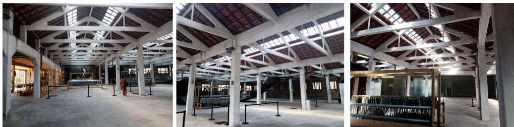
Figura 18. Treliças do antigo Curtume da Ramada. Fonte: fotos de Evelyn Lima, 2022.
