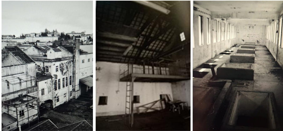
Figura 4. Situação do complexo fabril antes das obras: fachada, madeiramento do telhado e sala de fabricação com tanques. Fonte: fotos de Sebastião Resende, s/d.
