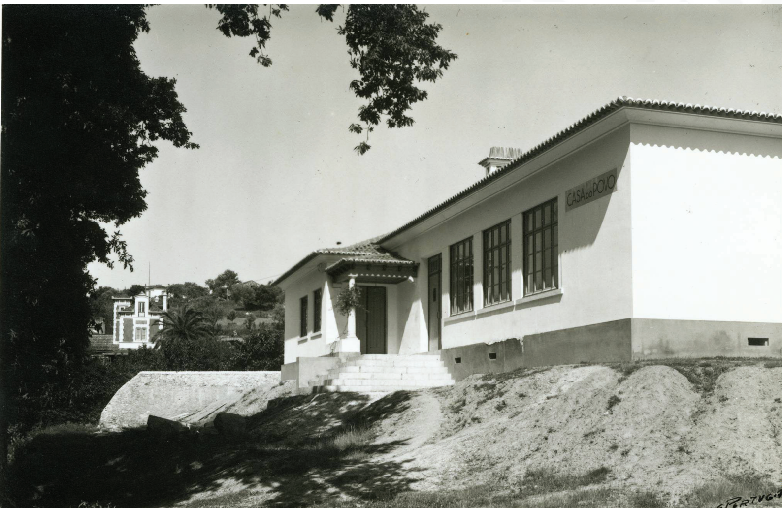
Figura 2: Sede da Casa do Povo de Figueiró dos Vinhos, realizada de acordo com o Projeto-tipo elaborado pelo arquiteto Jorge Segurado nos anos 1930. Fonte: Arquivo Municipal de Lisboa. Fotografia de Eduardo Portugal.
