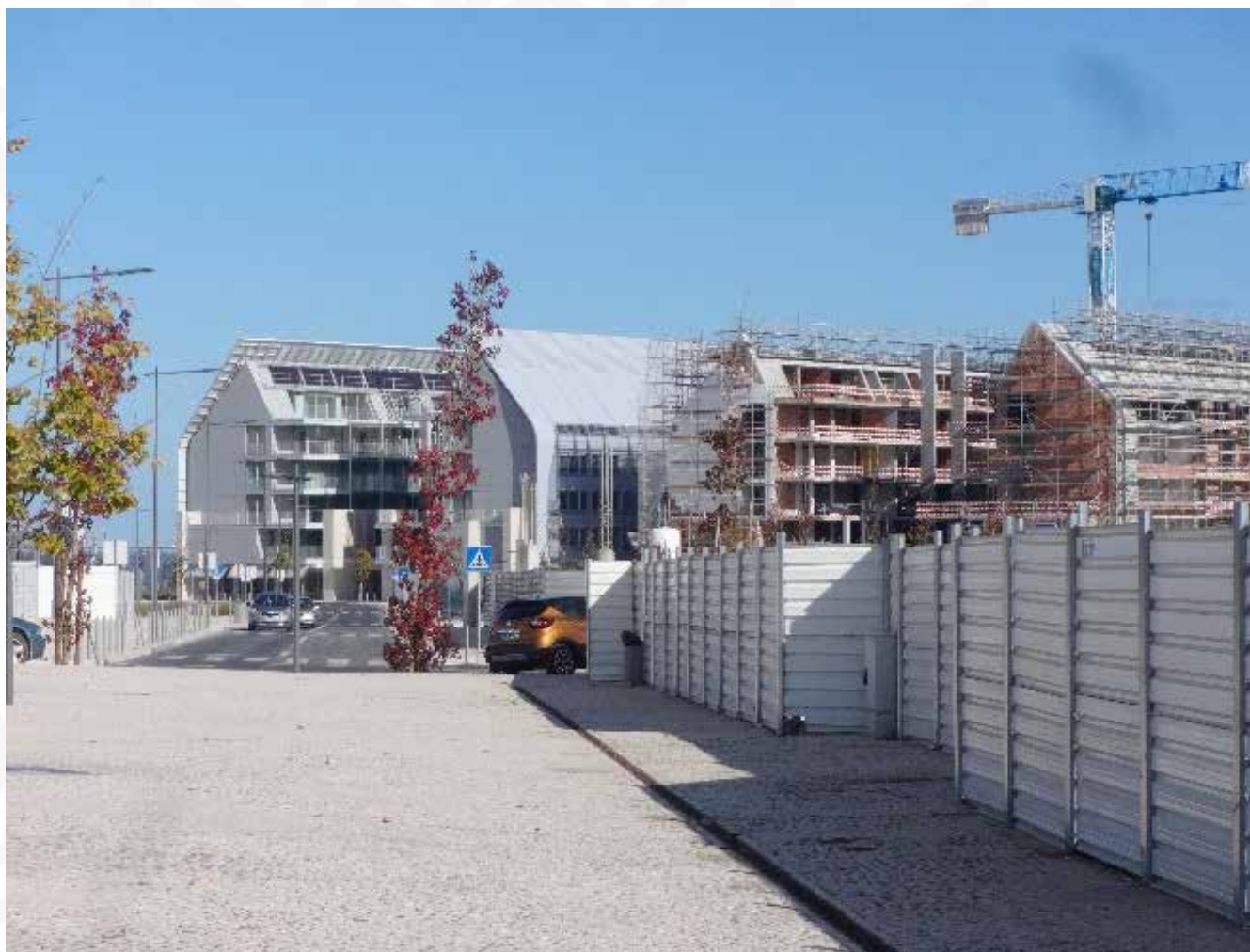
Figura 6: Vista do desenvolvimento do empreendimento privado “Jardins Braço Prata” / “Prata Riverside Village” / “Prata Living Concept”, sob construção, em Braço de Prata, Lisboa, Portugal. Fonte: Fotografia do Arquivo de Ana Nevado, 2019.
