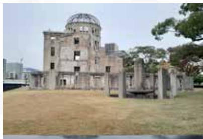
Figura 13. Cúpula da Bomba, Hiroshima/JAP. Foto Tomaz Lourenço em 16 nov. 2023
