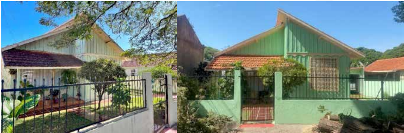
Figura 11: Edificação quadra 30, lote 11 – Rua Neo Alves Martins. Fonte: registro dos autores, 2022 e 2024.
