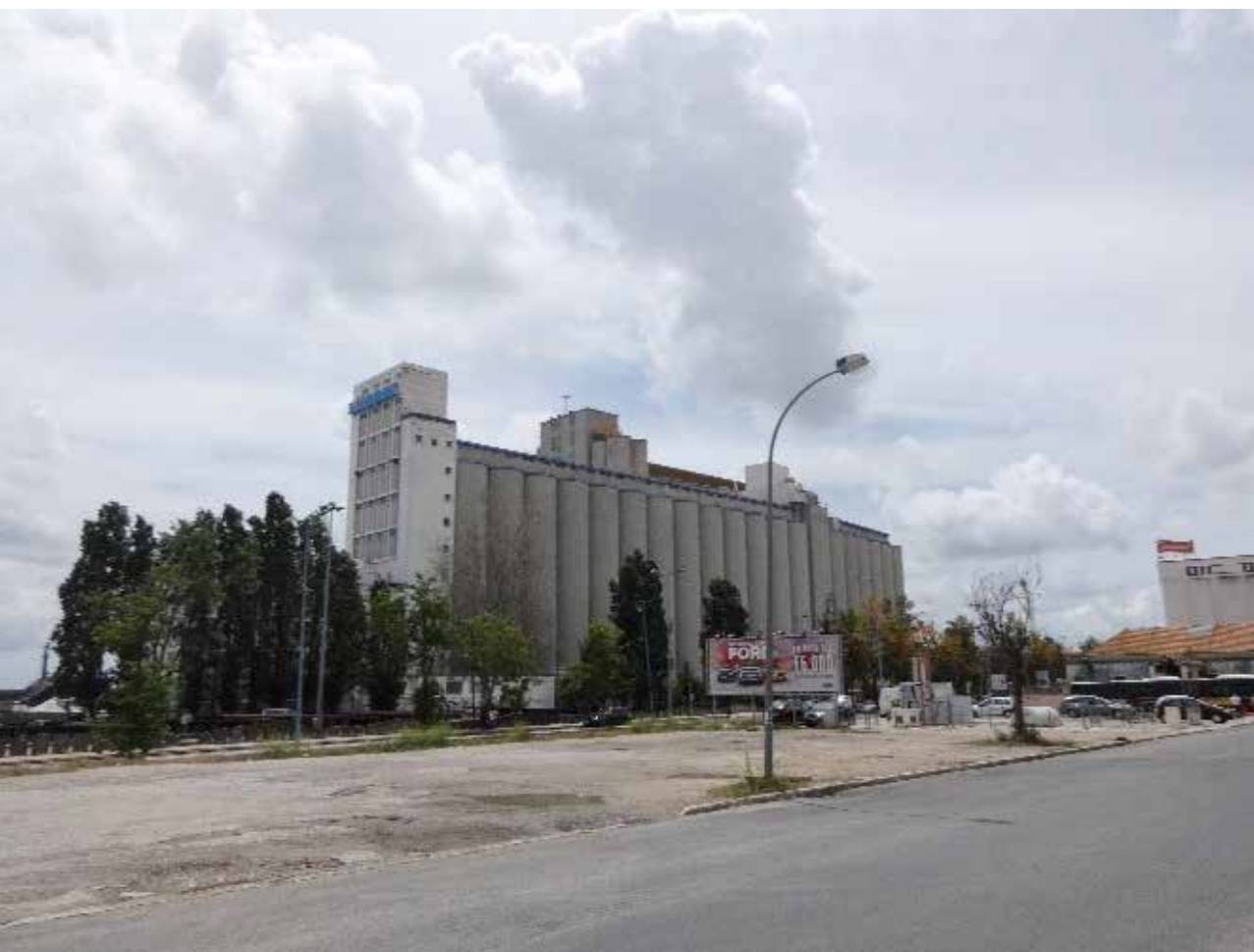
Figura 3: Vista da da Fábrica “A Nacional”, no Beato, Lisboa, Portugal. Fonte: Fotografia do Arquivo de Ana Nevado, 2017.
