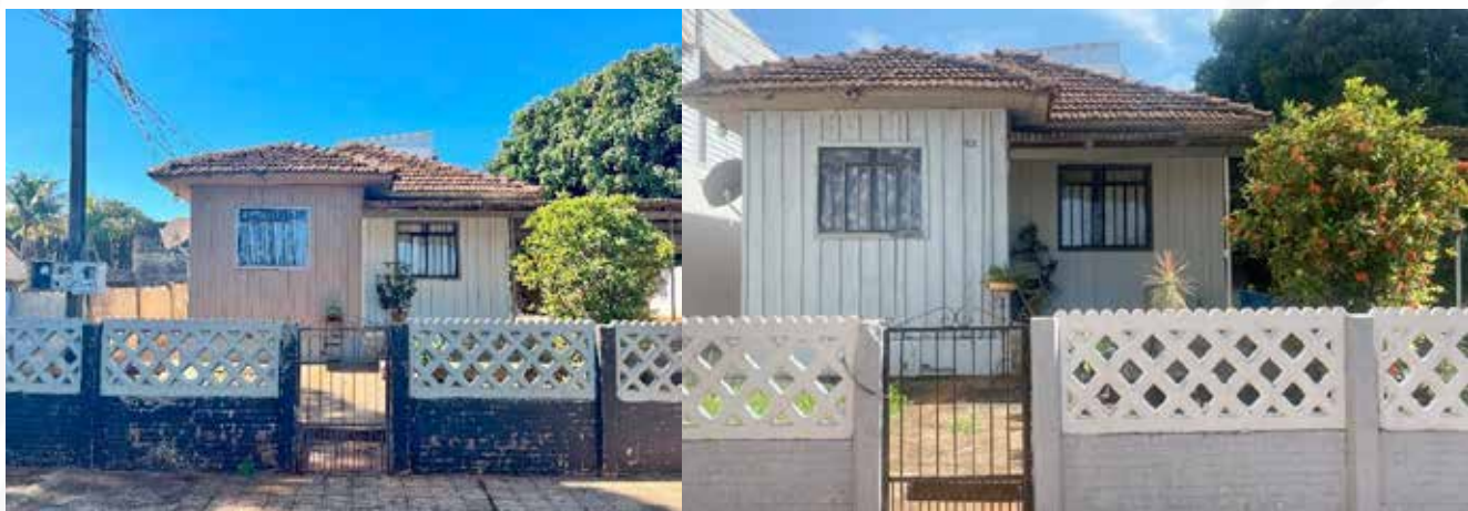
Figura 10: Edificação localizada na quadra 29, lote n. 09, na rua Neo Alves Martins. Fonte: registros dos autores, 2022 e 2024.
