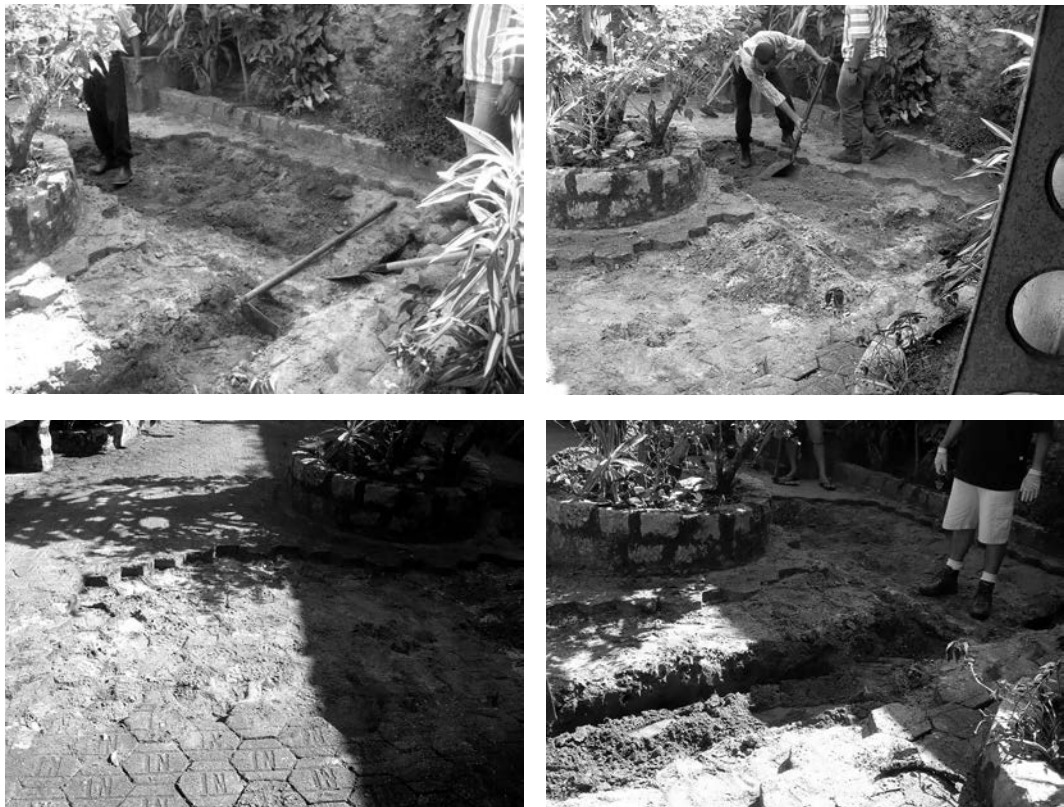
Fig.6. Retirada das lajotas e início das escavações
