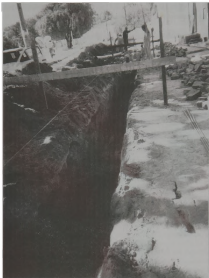
Foto 2 – Abertura de trincheiras e assentamentos da rede de água.
