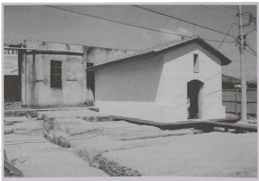
Fig. 2 – Vista atual da capela de Nossa Senhora da Escada, inserida no registro arqueológico do antigo aldeamento de Barueri. Foto André Nicoletti.
