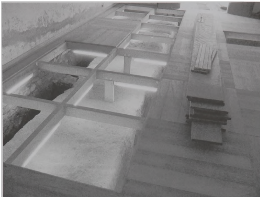
Fig. 5 – Vista do piso atual da capela de Nossa Senhora da Escada, deixando em exposição a fundação da parede de taipa de pilão da antiga igreja, os diferentes pisos de ocupação e os vestígios de enterramentos. Foto André Nicoletti.
