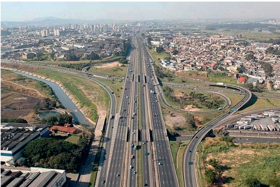
Fig. 15. Ao centro, a Rodovia Presidente Dutra (BR-116). À esquerda, o Ribeirão Cabuçu, e, transversalmente, a Rodovia Fernão Dias. Fonte: DNIT.
