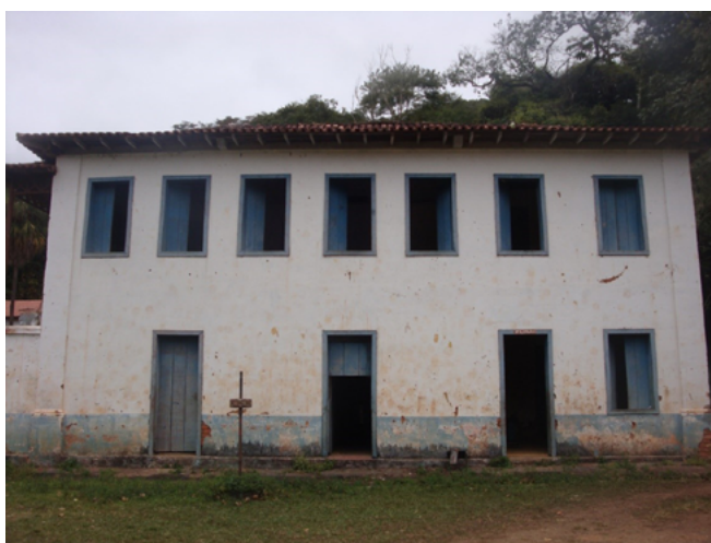
Fig. 3. Fachada de uno de los edificios del antiguo establecimiento esclavista –Fazenda– transformado en prisión arbitraria por la dictadura.
