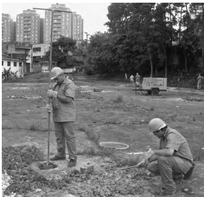
Fig. 2. Escavação de poço-teste.
