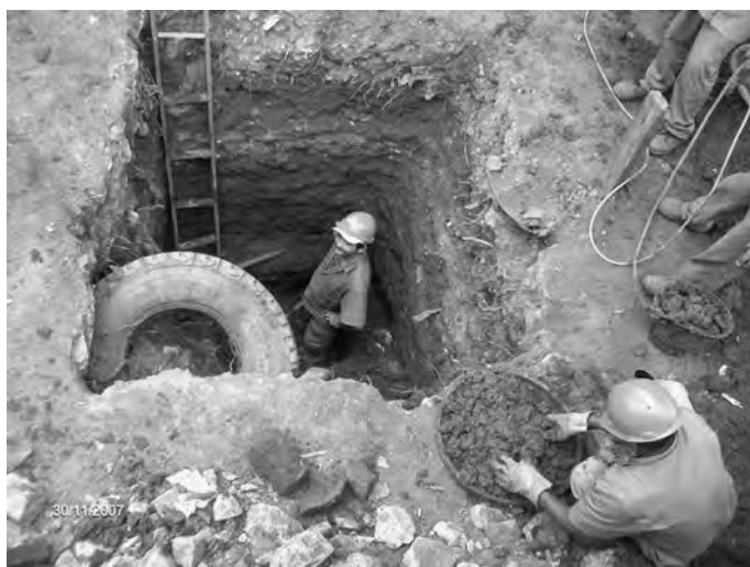
Fig. 3. Escavação de sondagem.
