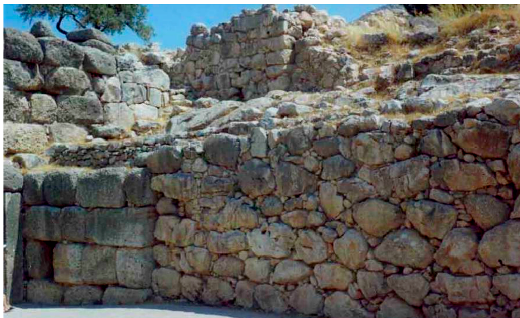
Fig. 4. Alvenaria ciclópica com corte retangular (esquerda) e blocos sem corte retangular com pedras menores conectando os interstícios entre blocos (direita).
