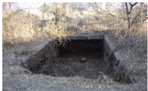
Fig. 11. Caixão alimentador da Fábrica Castanheiro. Fonte: Ribeiro (2018: 59).
