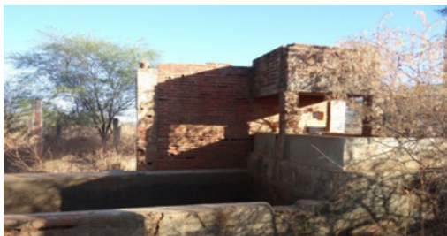
Fig. 9: Reservatórios de água e decantação. Fonte: Ribeiro (2018: 56).
