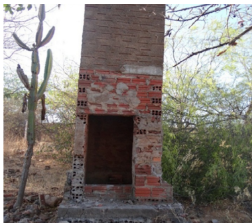
Fig. 4. Exaustor usado na dispersão de calor na Fábrica Castanheiro.
