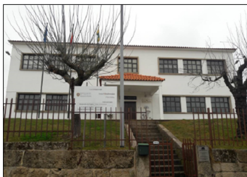
Fig. 7. Exemplo de escada na entrada do pátio. Destaque para o portão frontal aberto e para a porta principal de acesso fechada. Há portões fechados na lateral do edifício. Museu Municipal de Arqueologia Coronel Albino Pereira Lopo (MMARQ), Macedo de Cavaleiros.
