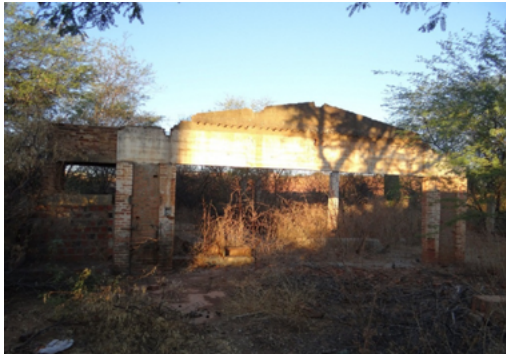
Fig. 8. Fachada da antiga Fábrica Castanheiro. Fonte: Ribeiro (2018: 54).
