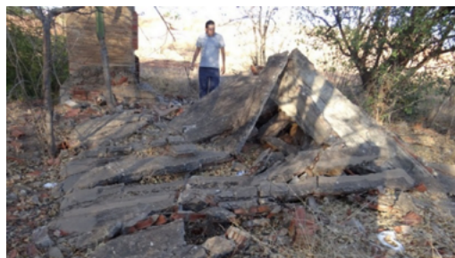
Fig. 5. Estrutura de laje que cobria a canaleta que se ligava ao exaustor.
