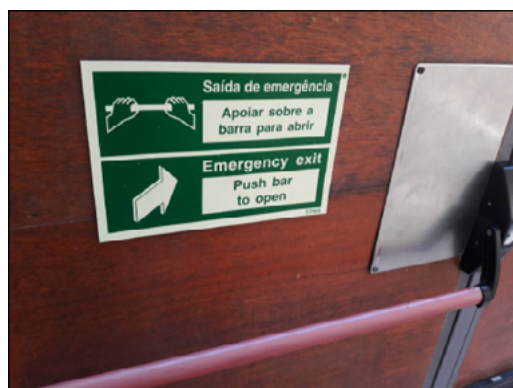
Fig. 3. Exemplo de sinalização de emergência em ambiente interno, Museu Arqueológico do Carmo (MAC), Lisboa.
