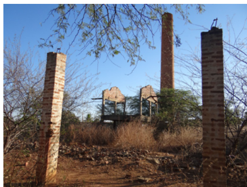
Fig. 2. Chaminé e estruturas do telhado da Fábrica de Cerâmica Castanheiro.
