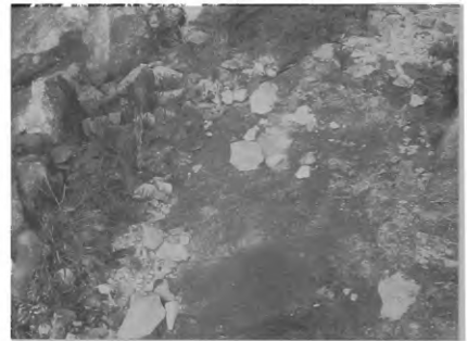
Material acumulado junto a blocos em patamar do piso inclinado.
