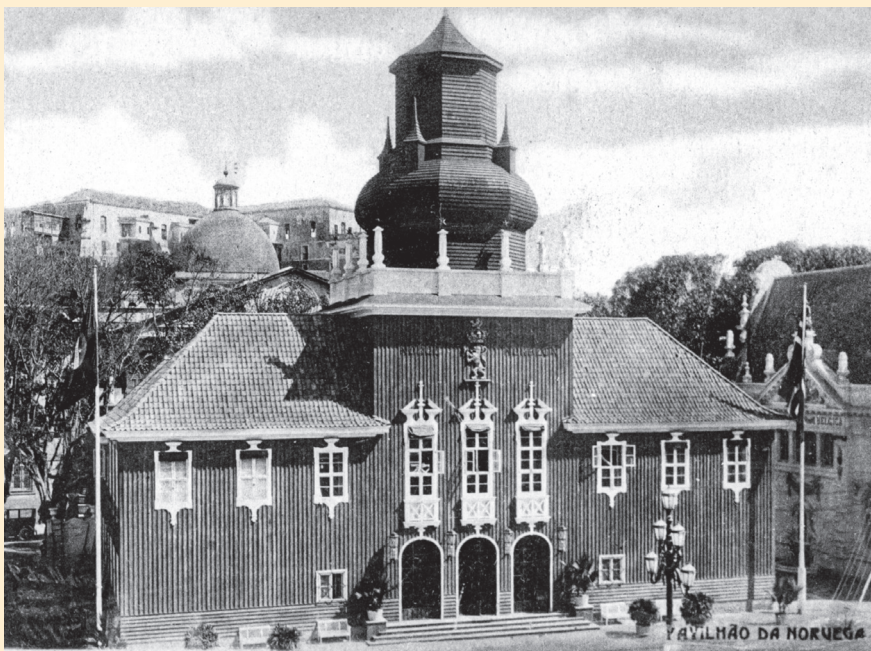
Fig. 25 - Pavilhão da Noruega, autoria desconhecida. A revista Fon-Fon de outubro de 1922 o descreveu: "O pavilhão construído no tradicional estilo norueguês das stavkirke ou igrejas de madeira das suas aldeias poéticas". Attilio Corrêa Lima, o urbanista de Goiânia, observou em 1936: "Por ocasião da 'Exposição do Centenário' de 1922, tivemos uma bela oportunidade para constatar a divergência profunda entre o gosto relativamente às cores. Os países aqui representados apresentavam uma variedade notável de aspectos, variando entre o marrom escuro do pavilhão norueguês à policromia brilhante do pavilhão mexicano". Cartão-postal, edição A. C. da Costa Ribeiro
