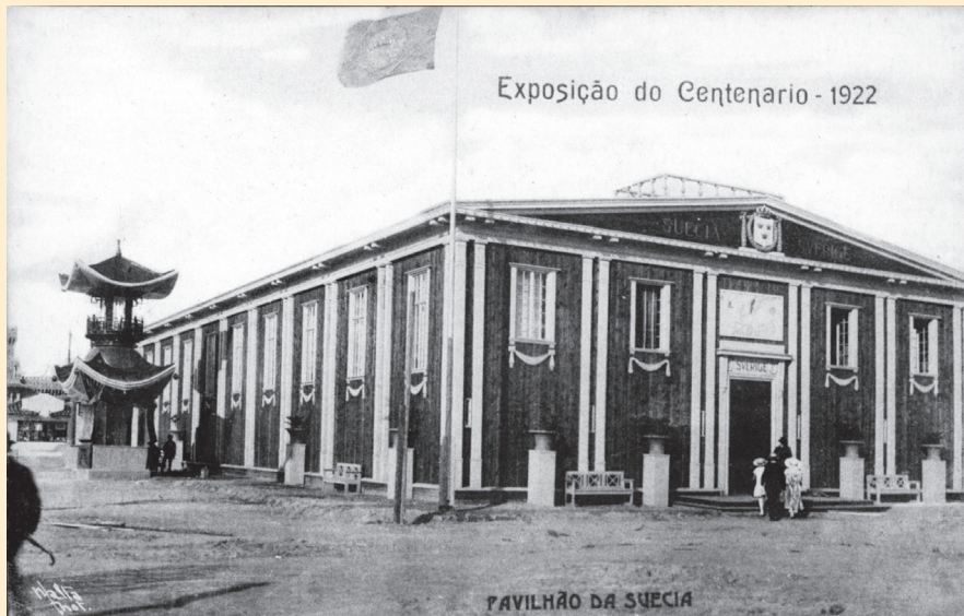
Fig. 28 - Pavilhão da Suécia, edifício pré-fabricado em madeira, de autoria desconhecida. O jornal O Paiz , registrando a inauguração da exposição, o qualificou: "Este pavilhão de estilo escandinavo...". Pouco impreciso, do ponto de vista arquitetônico, o gentílico adotado pelo jornal, considerando-se a participação da Noruega no mesmo espaço. Todavia, revela a disposição de tipificar formas para naturalizar estilos nacionalistas na identificação das representações estrangeiras. Cartão-postal, edição A. C. da Costa Ribeiro
