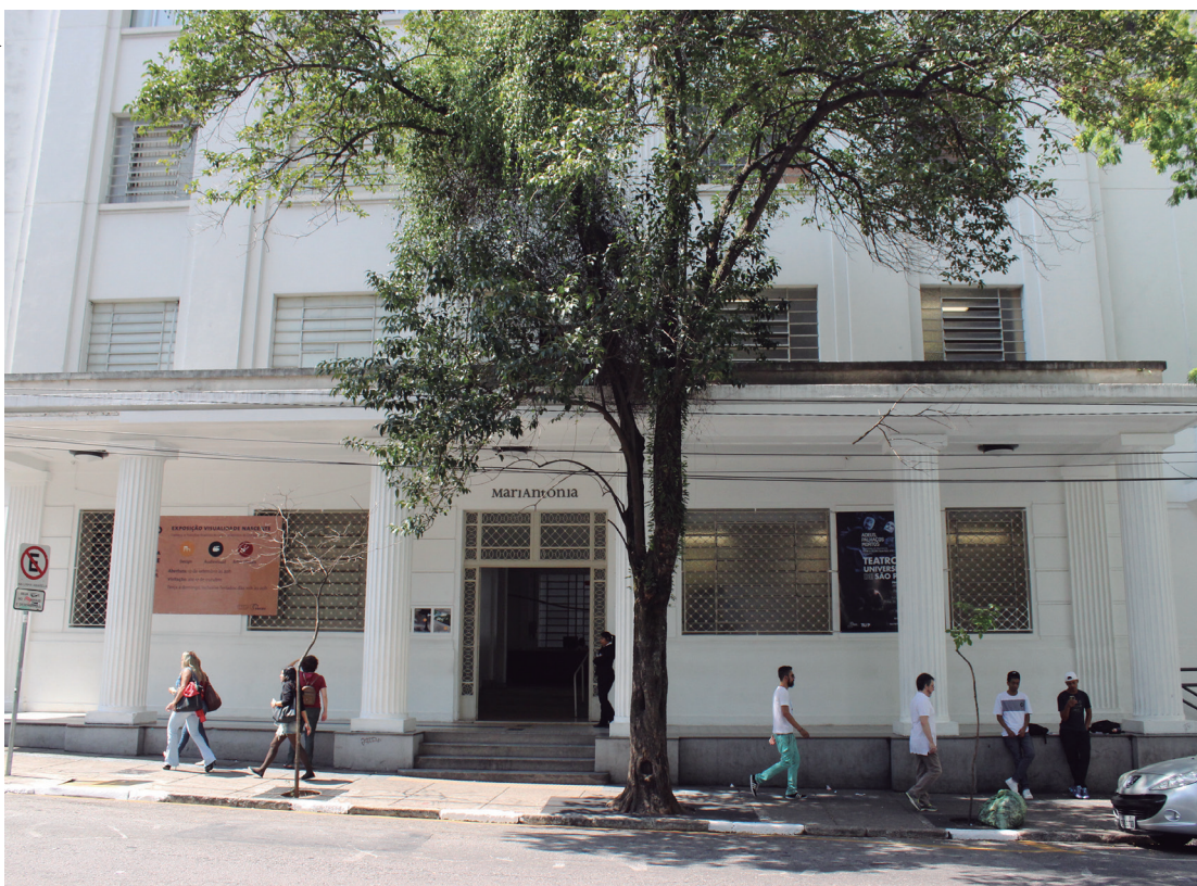
Aspecto atual da fachada do Centro Universitário MariAntonia da USP
