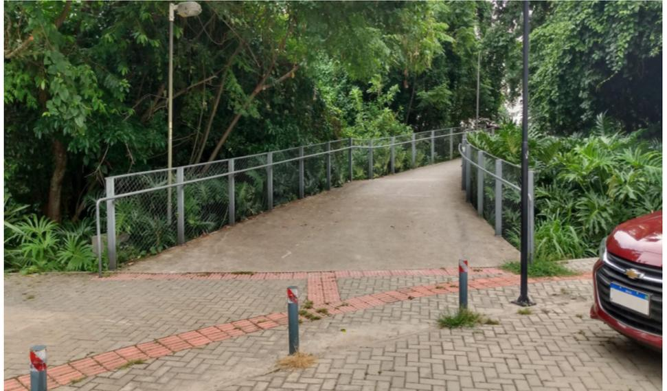
**Figura 7:** Piso tátil, balizamento e rampa no Parque Linear do Córrego Grande. Fonte: As autoras, 2021.
