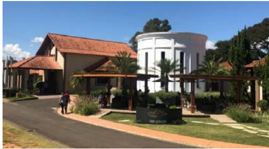
Figura 3 – Fachada da vinícola Casa Geraldo
