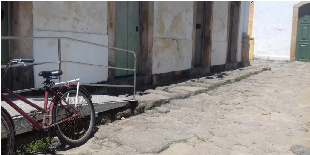
Figura 5: Sede da Câmara de Vereadores de Paraty; rampa de acesso ao imóvel, calçada com pedras pé de moleque.
