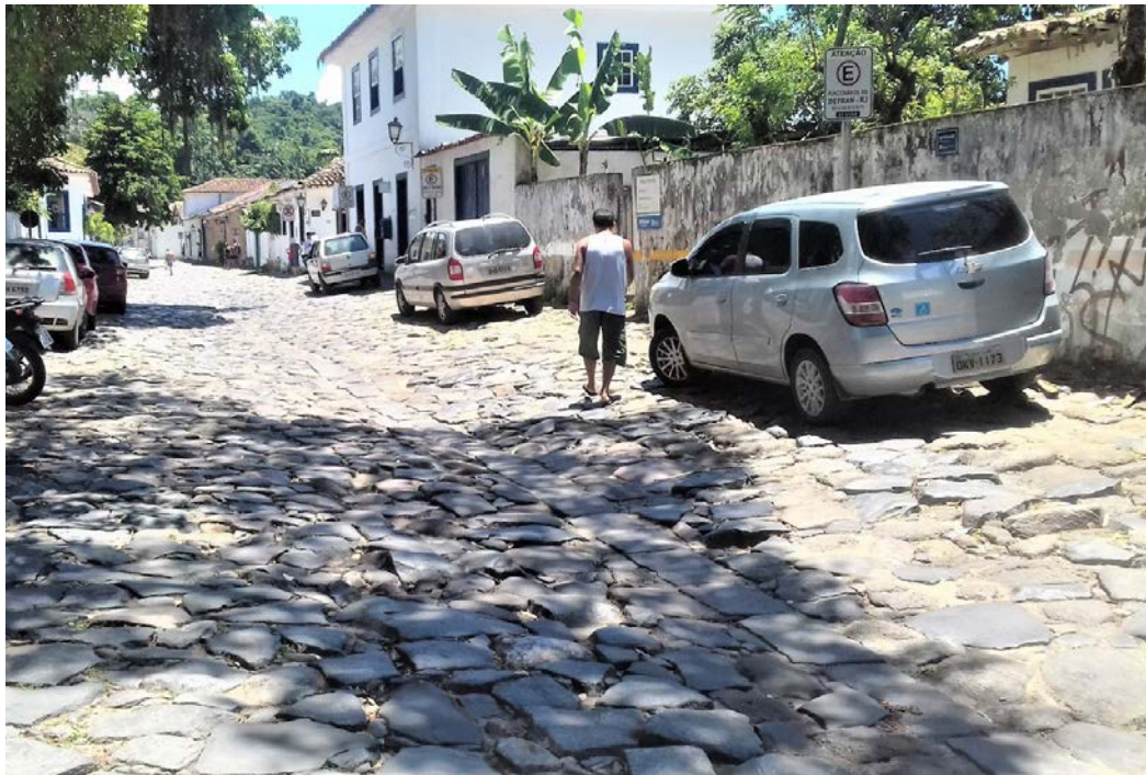
Figura 2 - Rua do Centro Histórico com calçamento pé de moleque e ausência de calçadas
