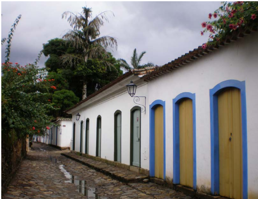
Figura 1 - Rua do Centro Histórico de Paraty, com calçamento pé de moleque.
