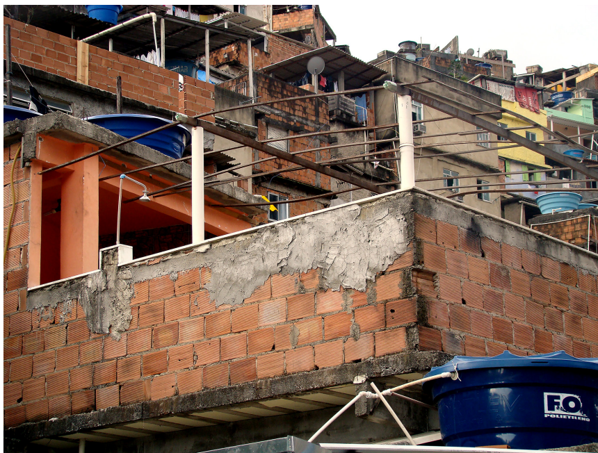
Figura 5: A laje é um elemento mutável, potencialmente em expansão. Vergalhões e tijolos aparentes não escondem o trabalho de quem a construiu (Bianca Freire-Medeiros; Fonte: acervo pessoal)
